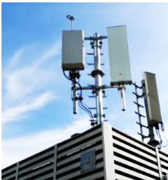
华为 Power Turbo 助力 5G 基站日均单站节能 3.5 度
