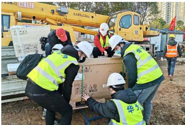
华为网络设备搬运现场
