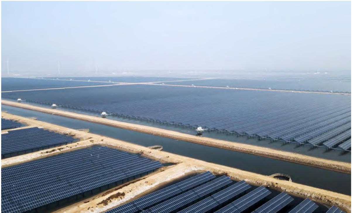
中国山东滨州沾化“渔光一体”项目
